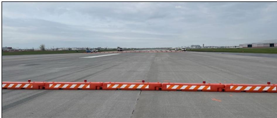
Figure 2. Barricades à profil bas avec feux d'obstruction
