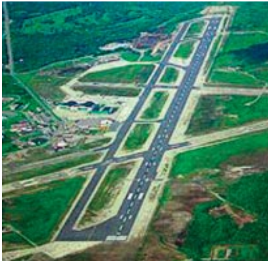
Photo 5-2 - Aéroport de North Bay
